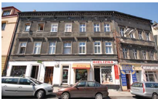
Budynki czekają na renowację.
